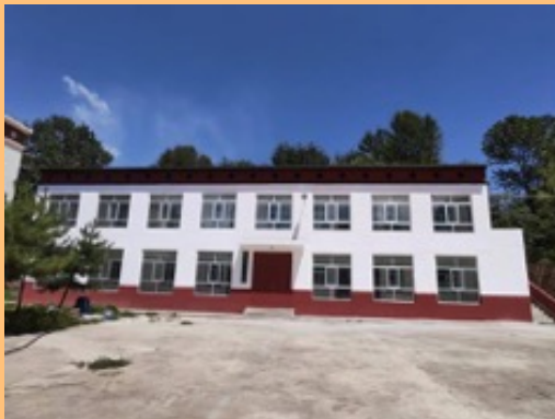
Nach der Renovation
